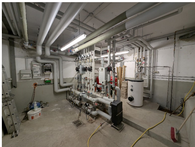
Fernheizung UG Haus B
