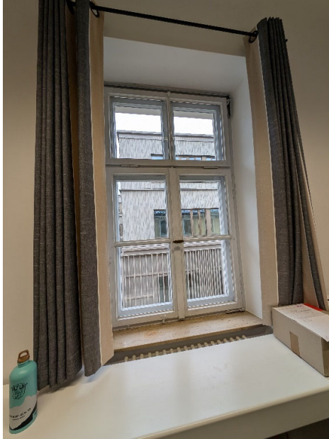
Historische Fenster Haus B
