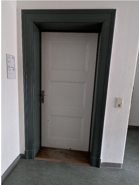
Historische Innentür OG Haus C
