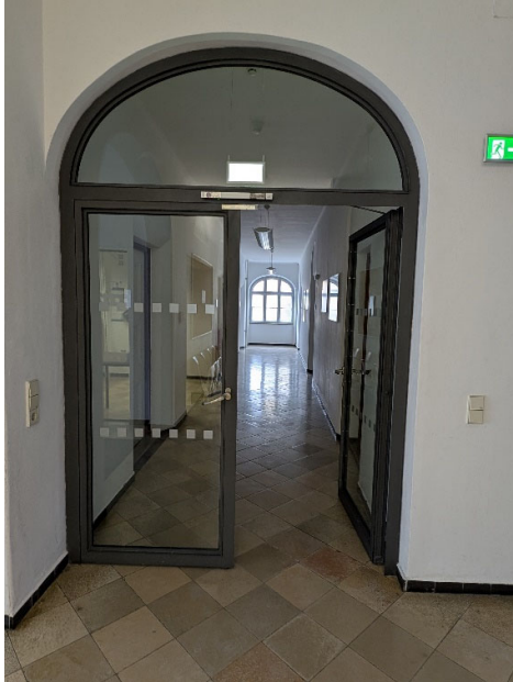
Rauchschutztüren Flure im Bestand
